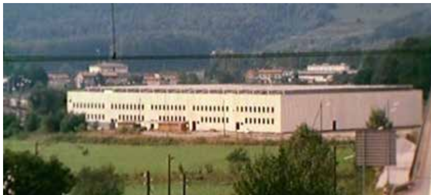
Capannone costruito a Balerna dalla ditta Boxer-Asbestos per la lavorazione dell'amianto. La foto è stata scattata nel 1978, il capannone non è mai stato messo in funzione.
