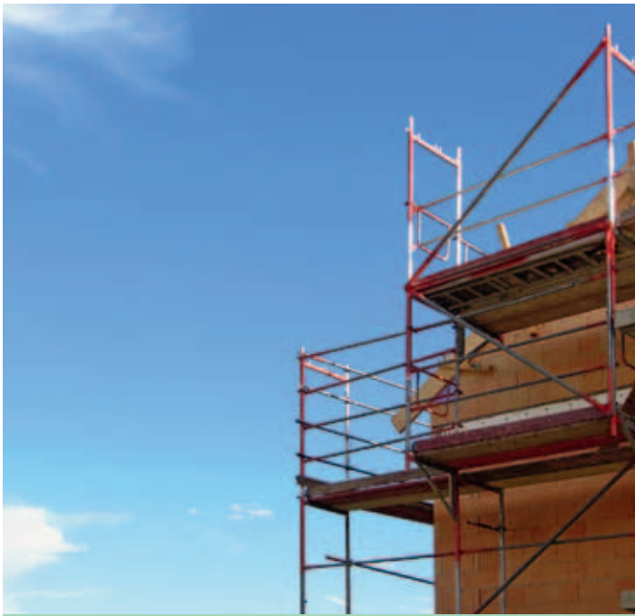
Construction de maison: aussi possible pour les couples concubins.
